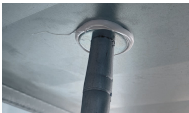
10. ábra – Átmenő rögzítés
